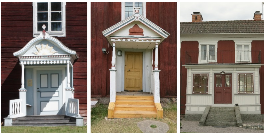
Figur 10.8: En praktfull brokvist markerade status. Till vänster (Ol-Anders, Alfta) och i mitten (Löka, Långhed) visas typiska brokvistar från mitten av 1800-talet. Till höger (Pallas, Roteberg) visas ett exempel på en brokvist som byggts om till en sekelskiftsveranda för att passa den tidens ideal, foto Fia Johannessen.
