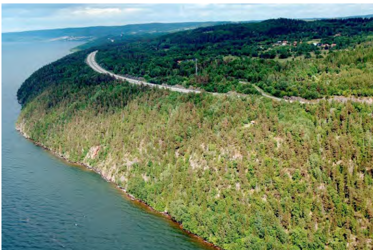
Illustration 11. Delar av kärnområdet i Vättern och på land, samt buffertzonen ovanför motorvägen.
